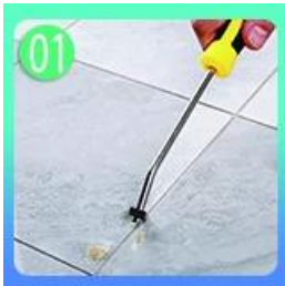
將填縫劑填入瓷磚縫隙中
