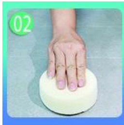
用填縫劑浮筒將填縫劑抹平
