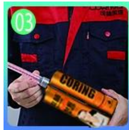
將填縫劑擠入瓷磚縫隙中
