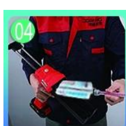
04 將美縫膏填入牆面瓷磚縫隙中，grout
