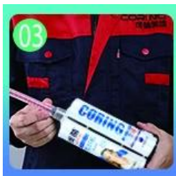
03 將美縫膏填入牆面瓷磚縫隙中
