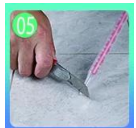
05 將美縫膏填入牆面瓷磚縫隙中，45度角
