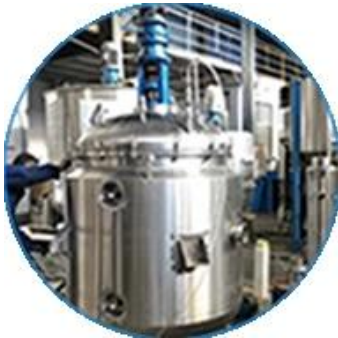
攪拌機 攪拌機
